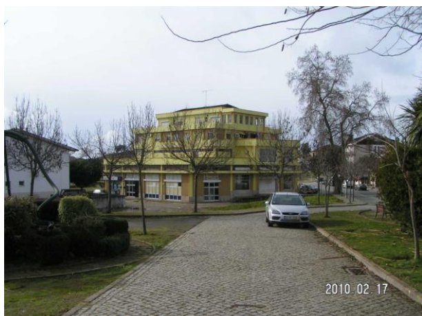
Foto n.º 8: Vista Geral do “Largo do Prado” – cota alta
