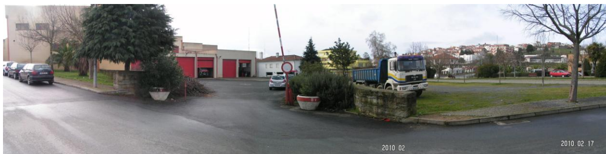
Foto n.º 7: Vista Geral do “Largo do Prado” – entrada do “Quartel dos Bombeiros – Futura localização do parque para auto-caravanas.
