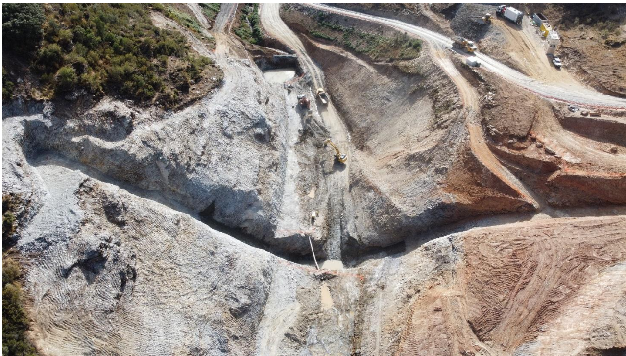
Escavação fundo do vale – setembro 2024
