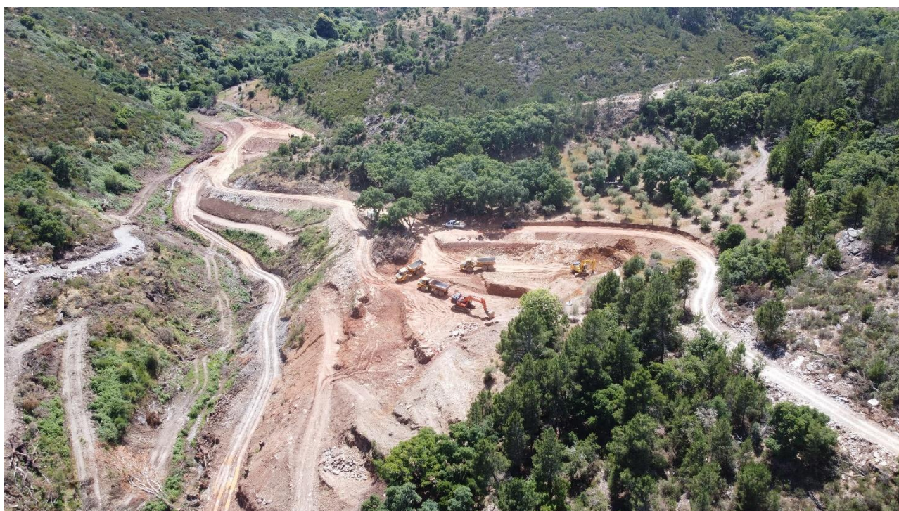
Escavação encontro esquerdo – junho 2024
