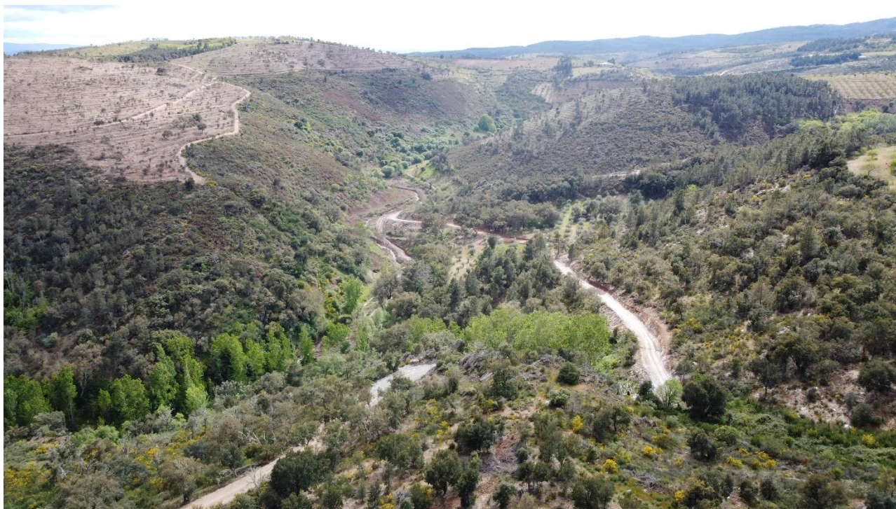
Abertura de caminho de acesso – maio 2024
