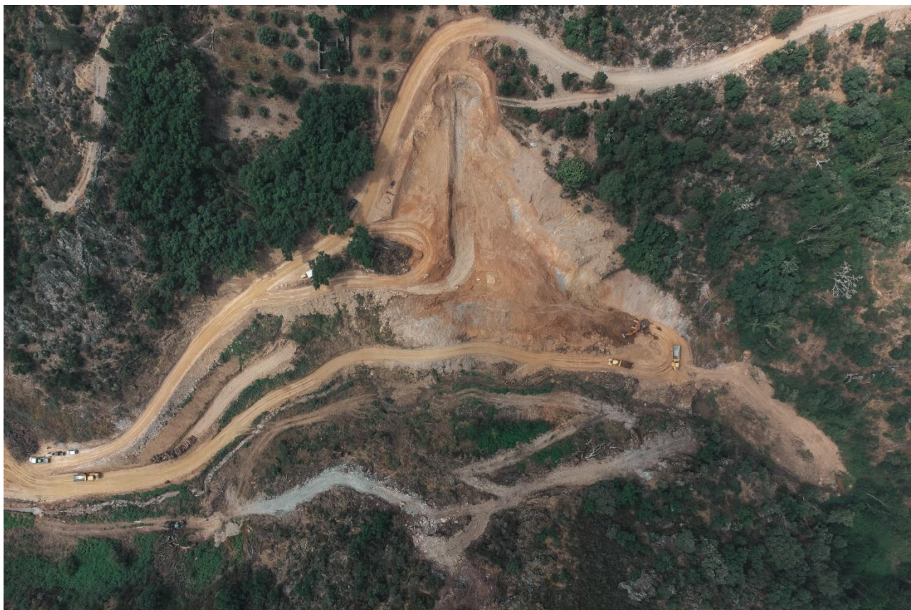
Vista aérea escavação encontro esquerdo – junho 2024
