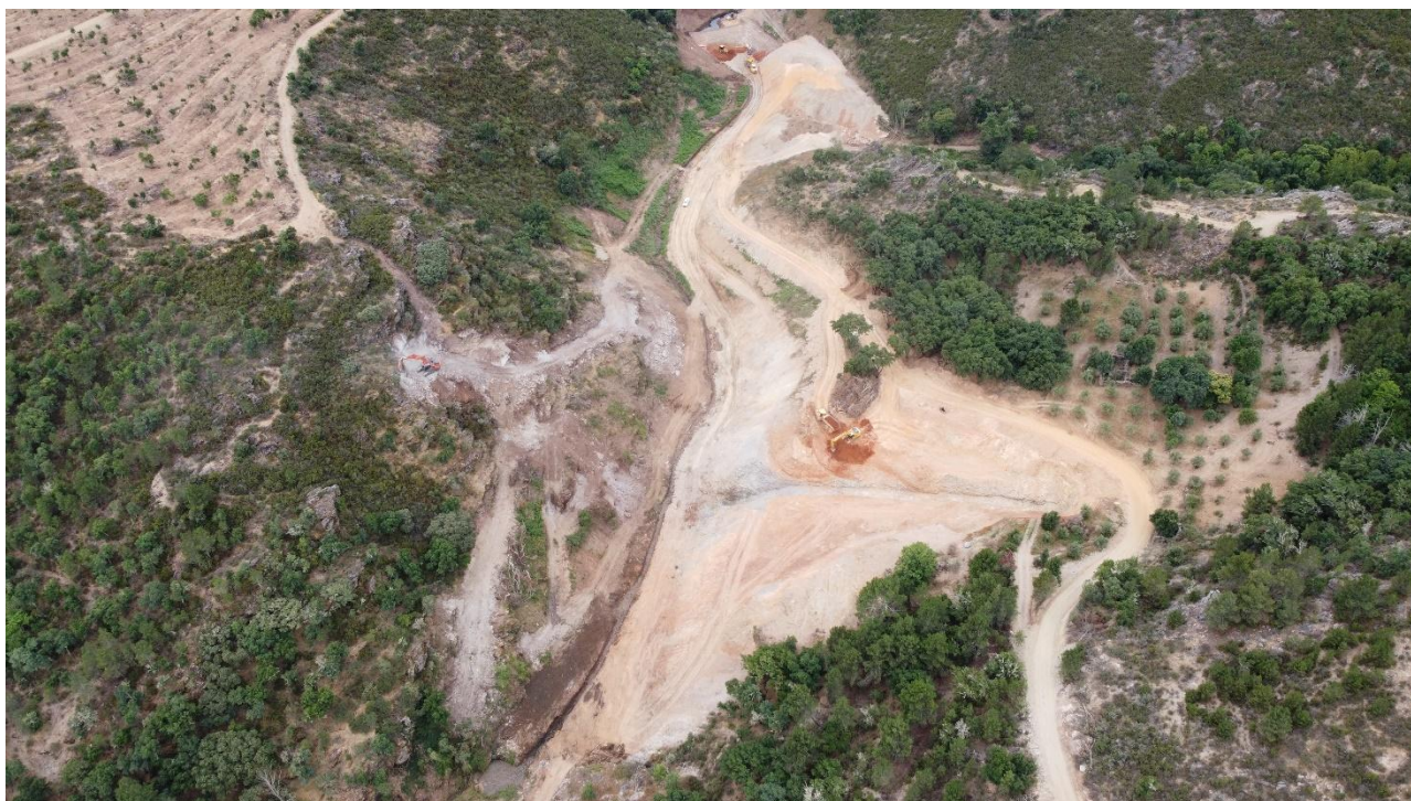
Início escavação encontro direito – julho 2024
