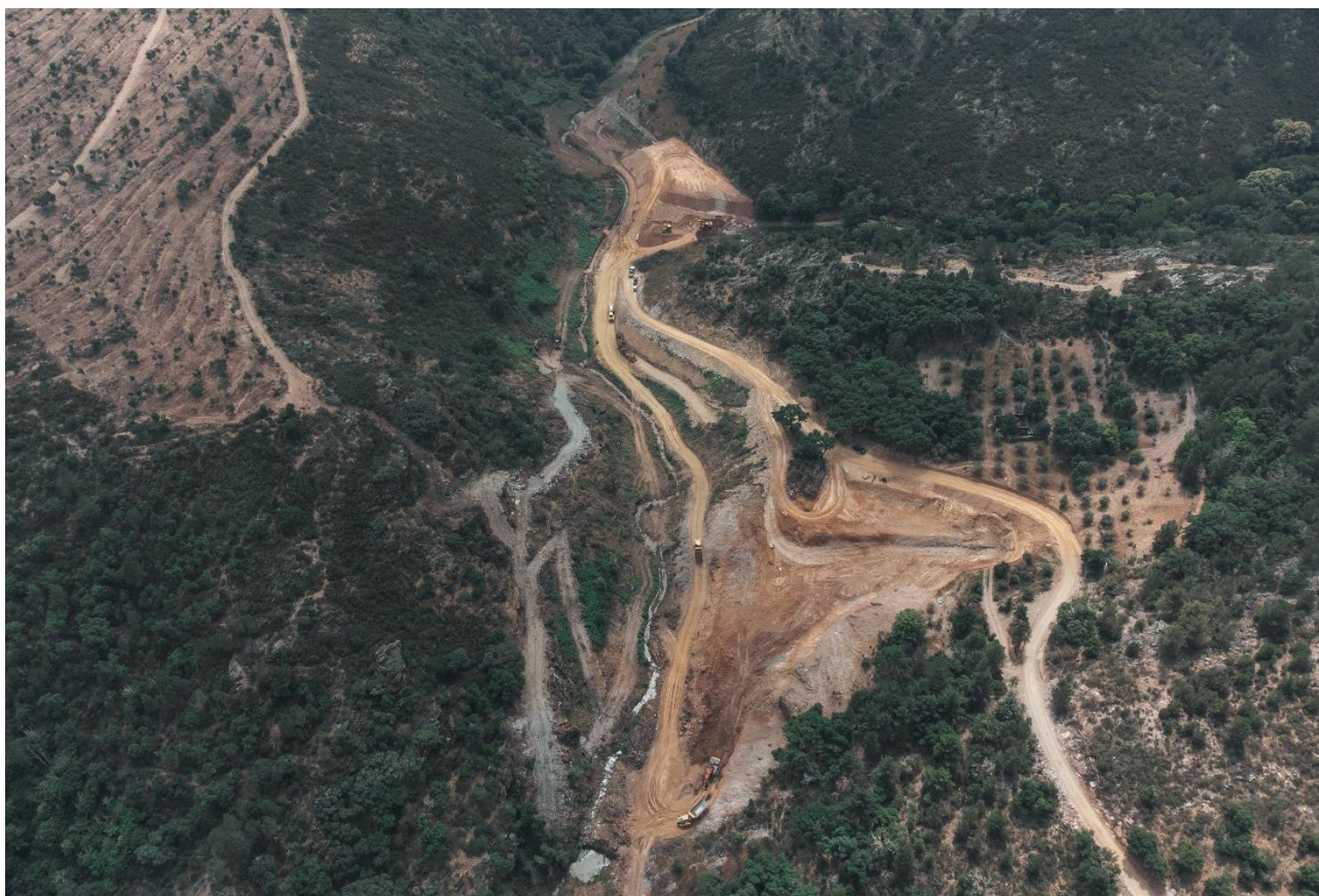
Vista aérea escavação encontro esquerdo – junho 2024
