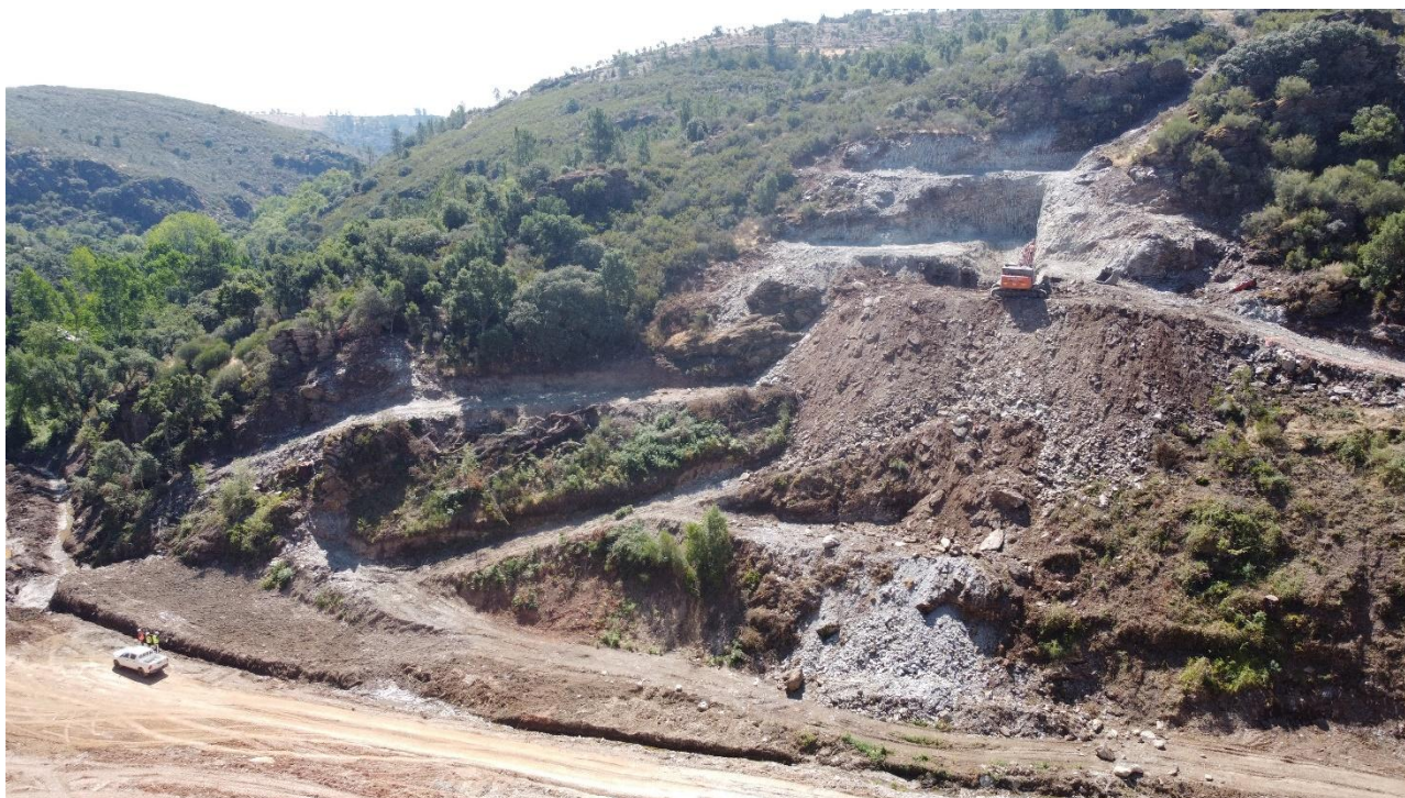
Escavação encontro direito – julho 2024
