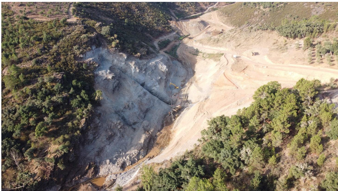
Escavação encontro direito – agosto 2024
