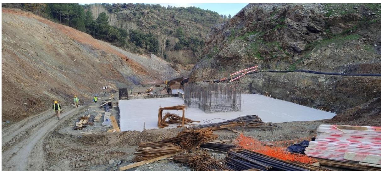
Aspetto final da sapata da torre de captação, arranque do pilar – novembro 2024
